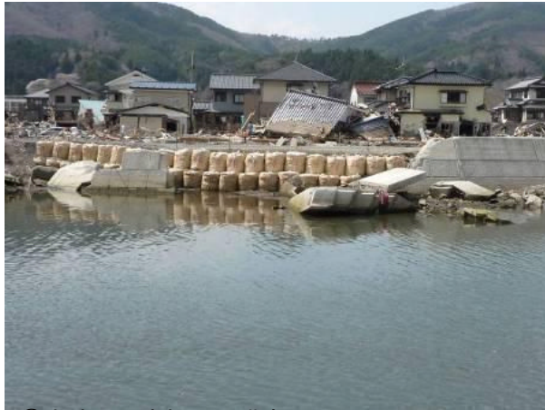
①崩壊した鹿折川の護岸
