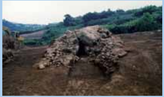
南から見た西長岡東山古墳群第3号墳の横穴式石室天井の石が崩落している。
