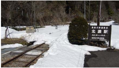
【写真 7：長良川鉄道北濃駅終端部】
