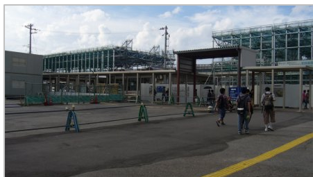
【写真 1：工事中の富山駅（2013.7.7）】
