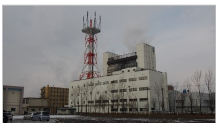
【写真 11：NTT 東日本苫小牧ビル】
